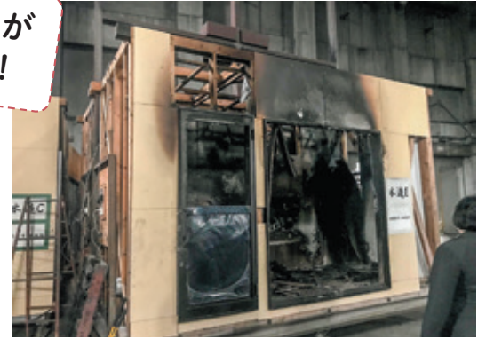
消防学校の訓練で燃やされた建物
